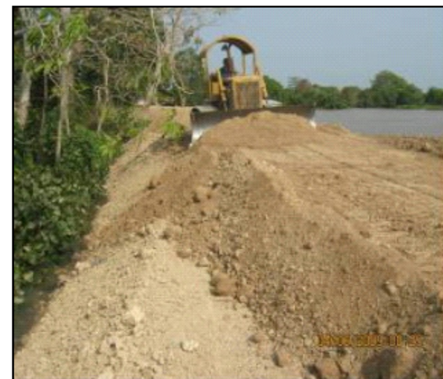
REALCE DIQUES CON MATERIAL COMÚN TRANSPORTADO EN LA PERIFERIA DEL CASCO URBANO
