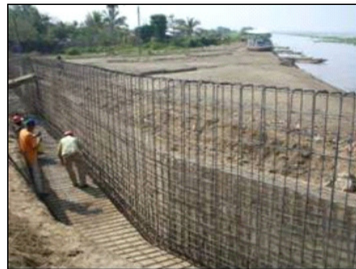
CONSTRUCCION MURO DE CONCRETO ARMADO
