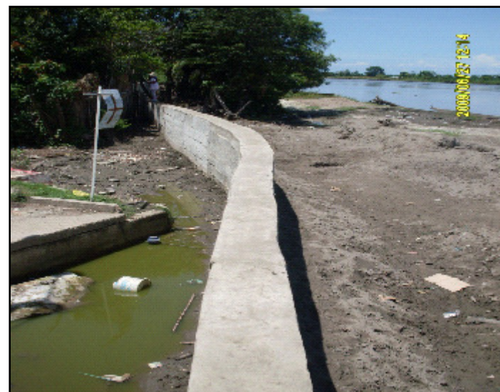
MURO EN CONCRETO REFORZADO CIERRE PUEBLO
