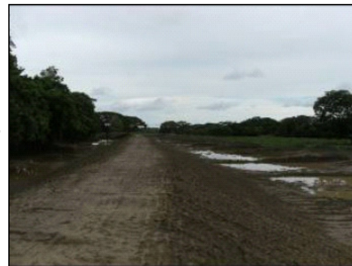
DIQUE CONFORMADO CON MATERIAL COMÚN DE PRÉSTAMO LATERAL
