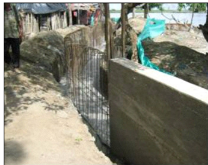
MURO EN CONCRETO REFORZADO CIERRE PUEBLO
