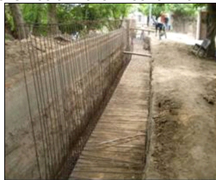
CONSTRUCCION MURO DE CONCRETO ARMADO
