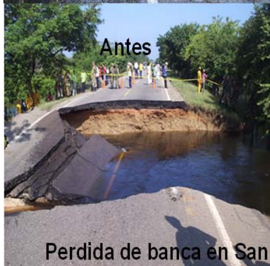
Perdida de banca en el PR55+950 Manizales - Fresno
