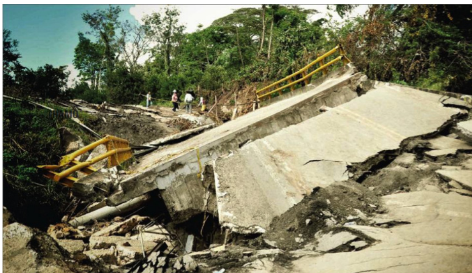
Figura 3. Daño causado a la Vía Bucaramanga – Barrancabermeja por el fenómeno de La Niña 2010/2011
