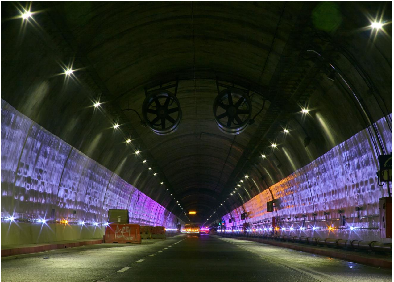
Foto 7-4. Sistema de ventilación, Túnel de La Línea
