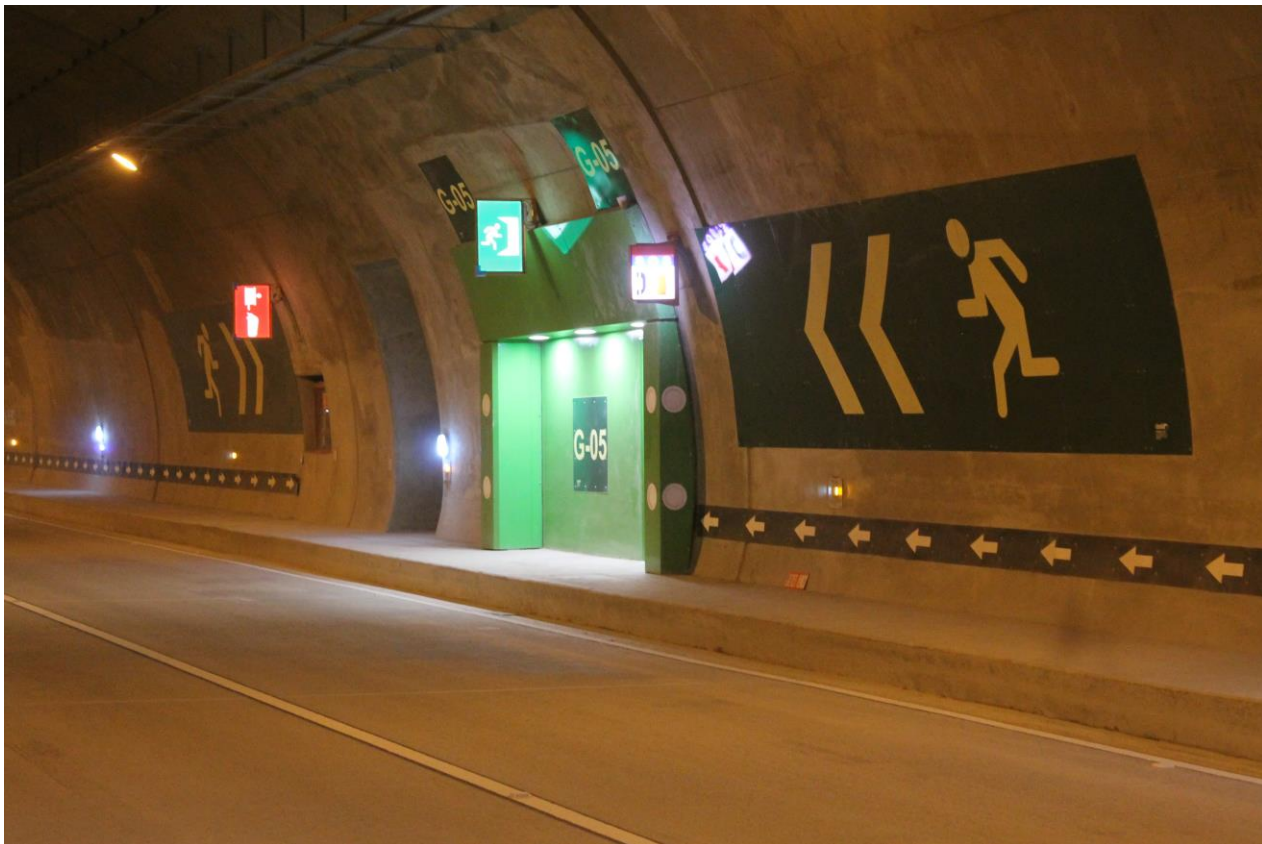
Foto 7-7. Galería de escape, Túnel Renacer, Quetame Cundinamarca con Revestimiento RCD.
