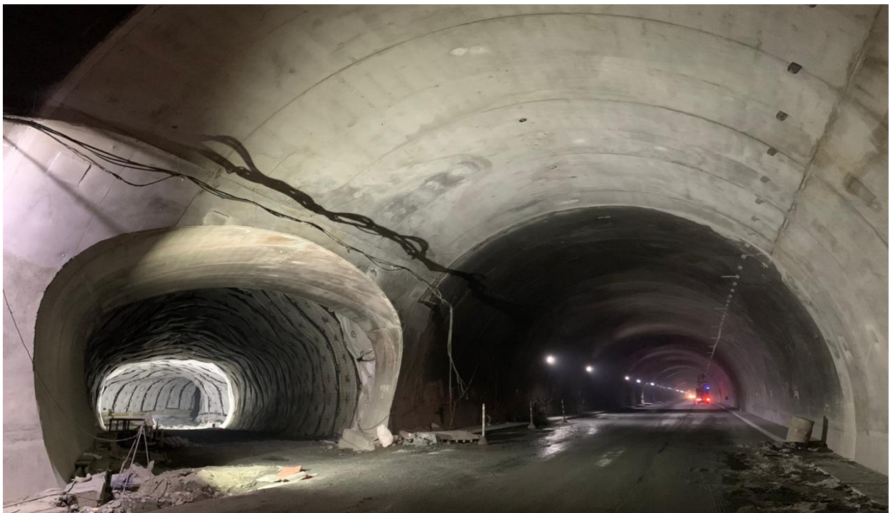
Foto 6-6. Revestimiento de capa doble RCD, Túnel Mulatos y Túnel de La Línea
