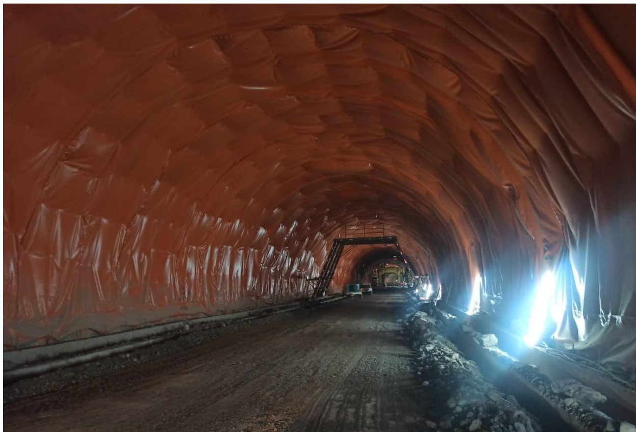
Foto 6-5. Impermeabilización para revestimiento definitivo, túnel Mulatos
