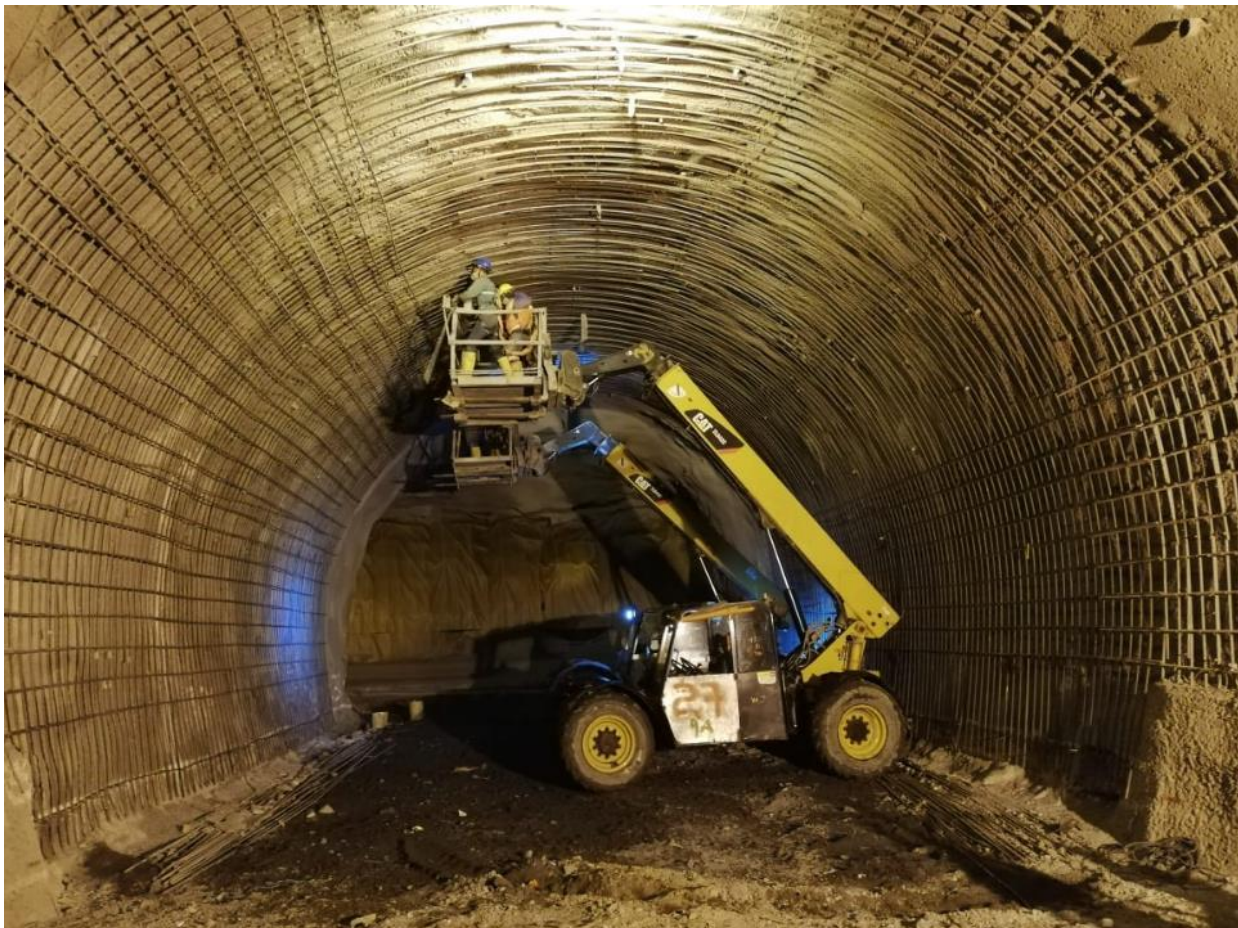
Foto 8-1. Proyecto cruce cordillera central, sostenimiento galería de evacuación
