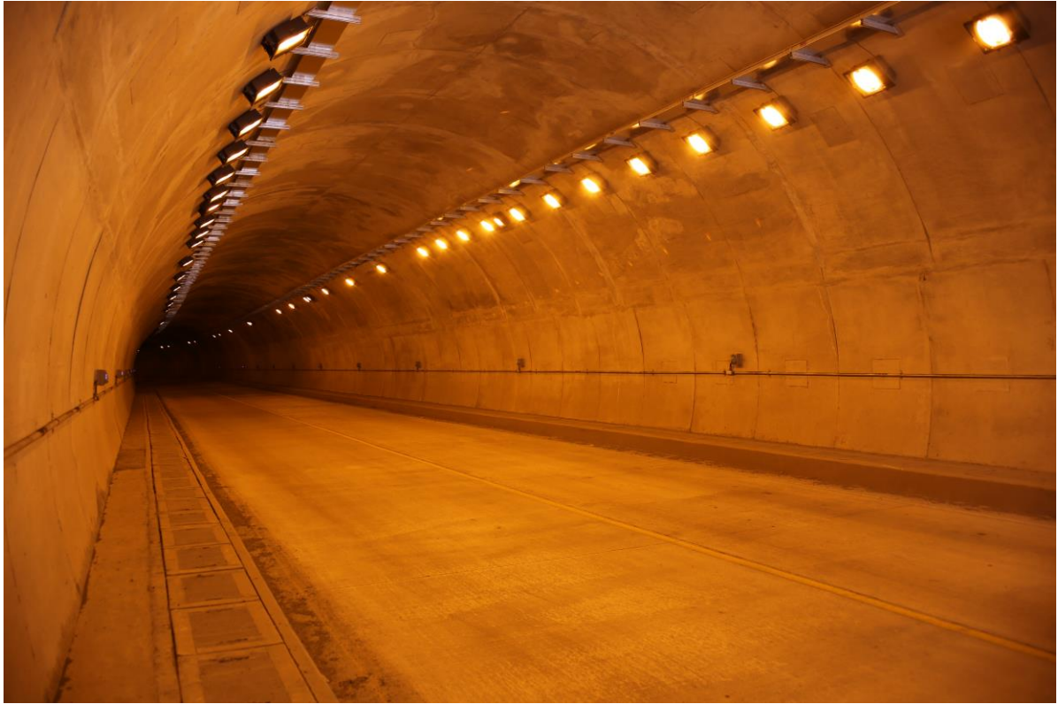
Foto 7-10. Iluminación homogénea en el túnel vía Cisneros Loboguerrero, proyecto Buga Buenaventura.
