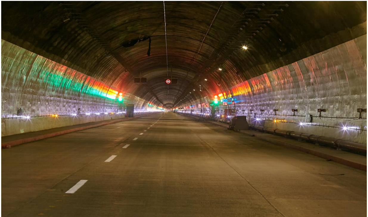
Foto 7-6. Sistema de iluminación, Túnel de La Línea con Revestimiento RCD.
