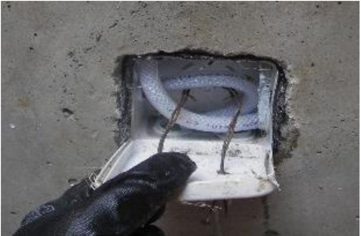
Foto 6-7. Caja de inspección para inyección de resinas en un sistema de compartimentación
