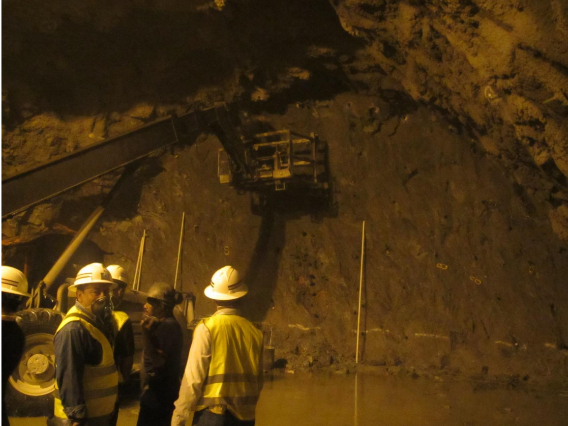
Foto 6-3. Cruce cordillera central, labores de perforación y voladura Túnel de la Línea
