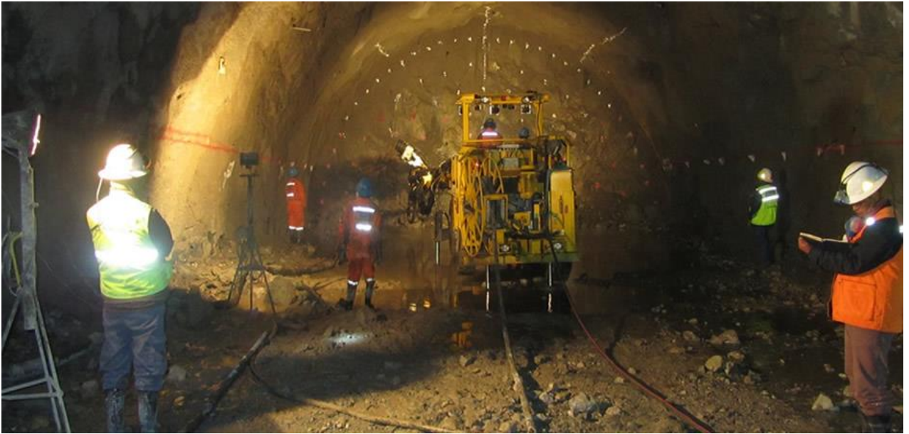
Foto 6-4. Sistema convencional de excavación – perforación y voladura de roca
