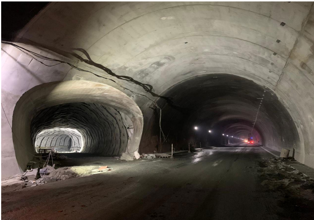
Foto 6 6. Revestimiento de capa doble RCD, Túnel Mulatos y Túnel de La Línea
