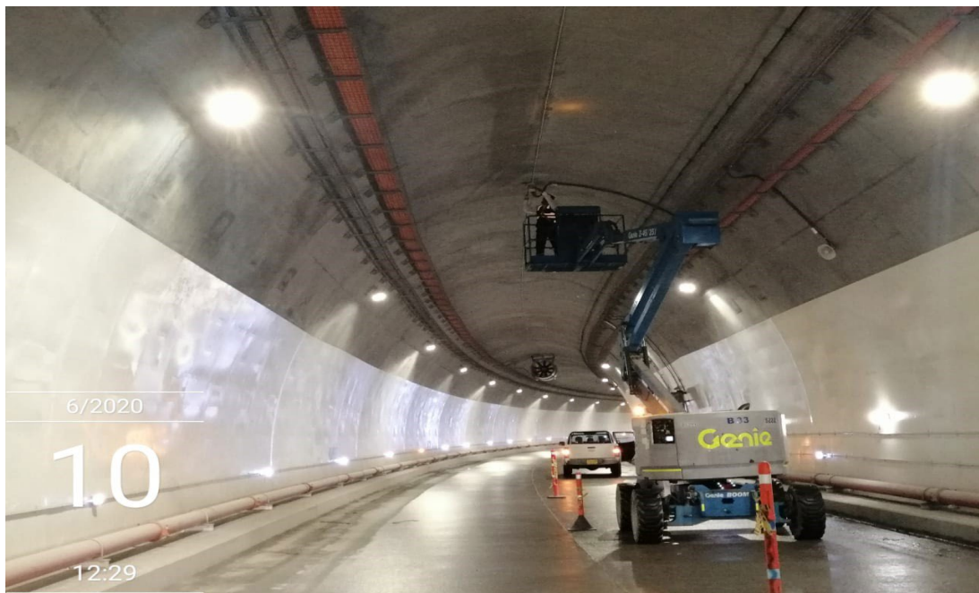
Foto 7-5. Diseño e instalación de sistema de ventilación, Túnel de La Línea
