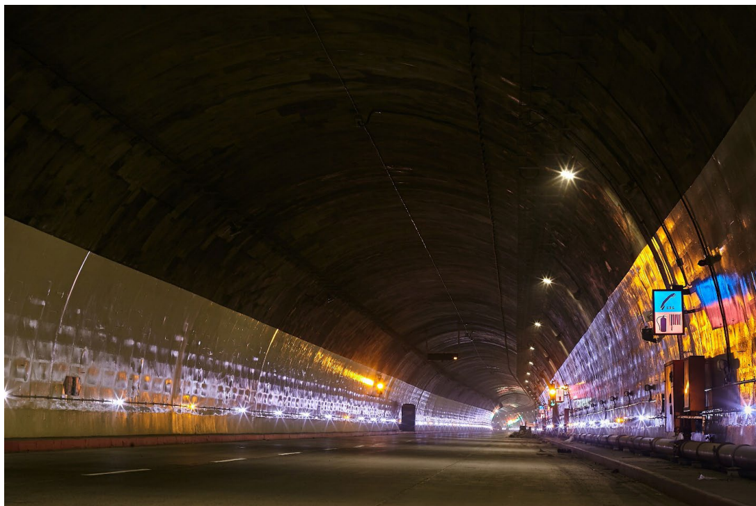
Foto 9-4. Sistemas S.O.S. y control contra incendios, Túnel de La Línea
