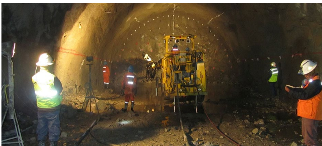
Foto 6-4. Sistema convencional de excavación – perforación y voladura de roca
