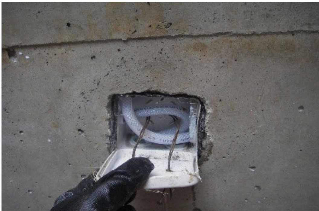
Foto 6-7. Caja de inspección para inyección de resinas en un sistema de compartimentación
