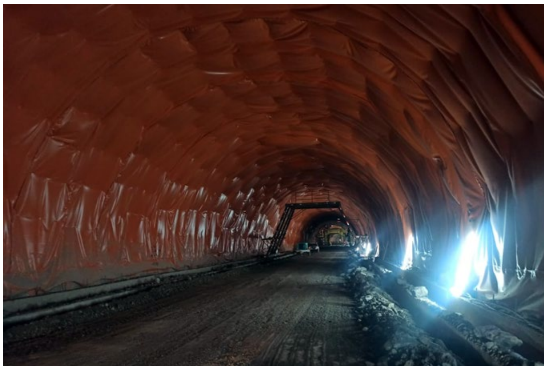
Foto 6-5. Impermeabilización para recubrimiento definitivo, Túnel Mulatos
