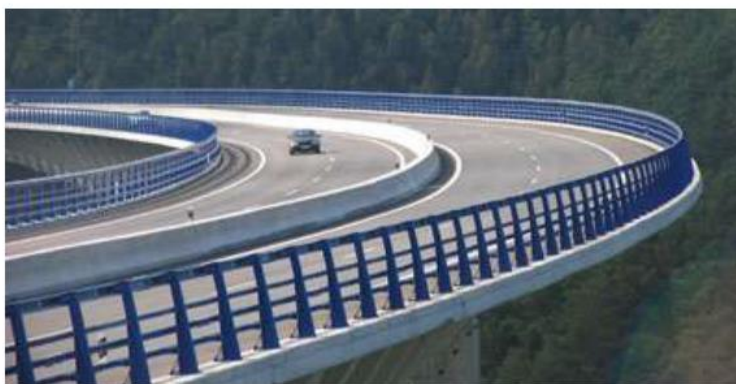
Ilustración 11. Pretil en puente vehicular
