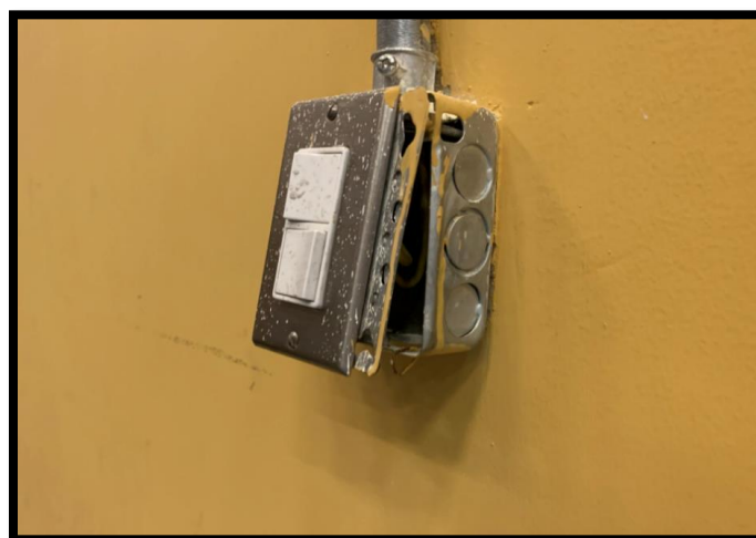
Oficina de comunicaciones, con cable de datos y eléctrico desorganizado, ductos en las partes superiores con cableado externo y cajas de paso sin tapas.
