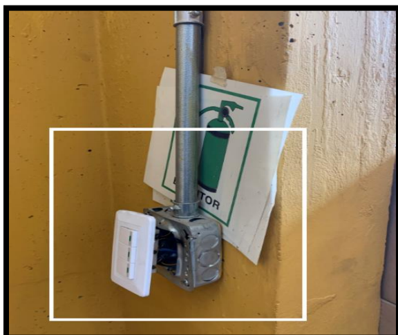
Bodega norte, suiches de encendido dañados
