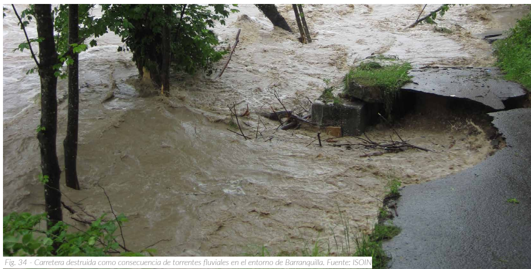
Fig. 34 - Carretera destruida como consecuencia de torrentes fluviales en el entorno de Barranquilla. Fuente: ISOIN
