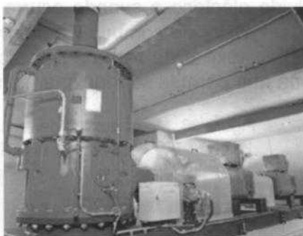
Figura 34. De color azul y al frente se observa un reductor de un sistema circulante.
