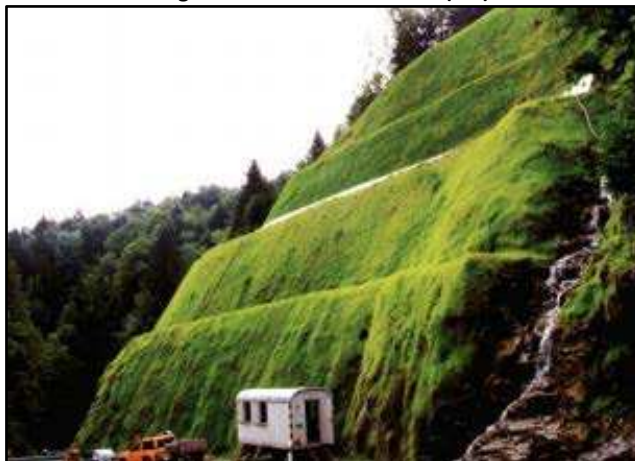
Figura 5-3 Talud escalonado (5.8)
