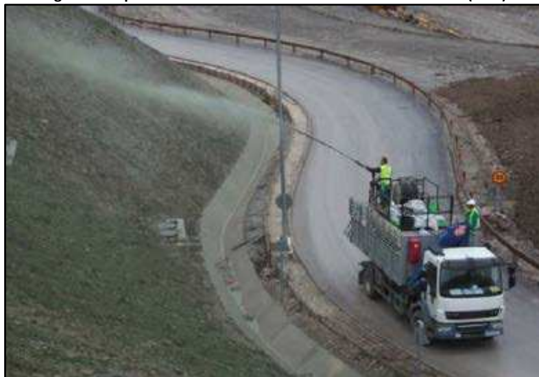
Figura 5-6 Aplicación de hidrosiembra sobre un talud de corte (5.11)
