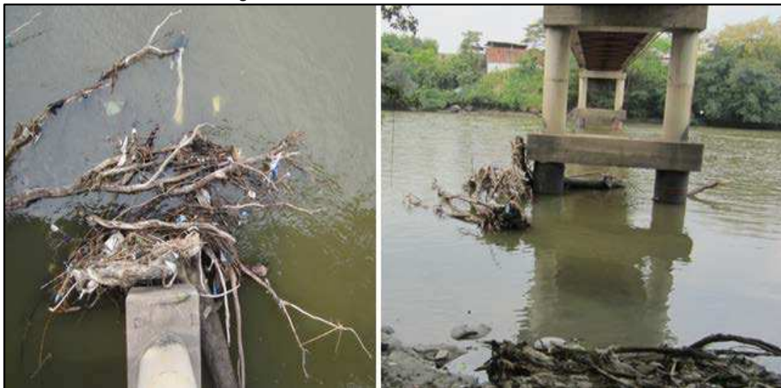
Figura 5-20 Presencia de obstáculos en el cauce
