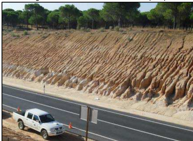
Figura 5-4 Erosión de un talud de corte (5.11)
