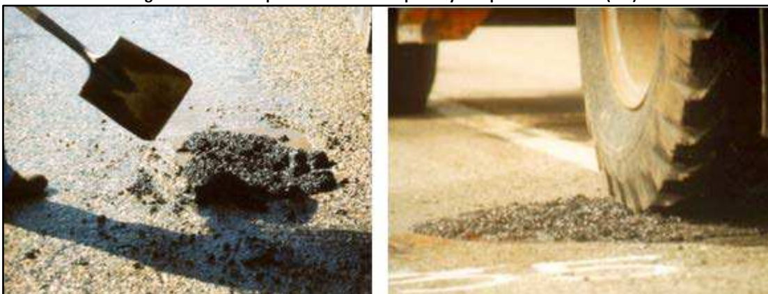
Figura 7-6 Parcheo por el método de esparcir y compactar la mezcla (7.8)
