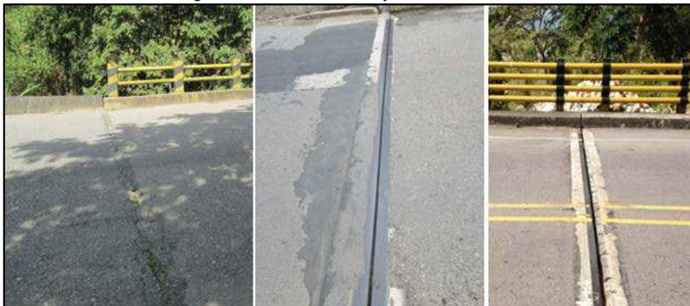
Figura 5-15 Deterioros en las juntas de dilatación
