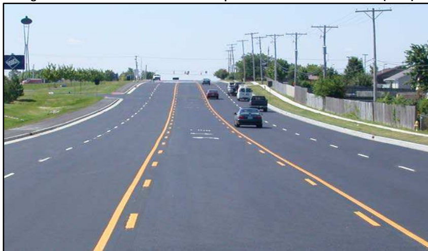
Figura C7A-1 Pavimento asfáltico con superficie en buenas condiciones (R = 0)
