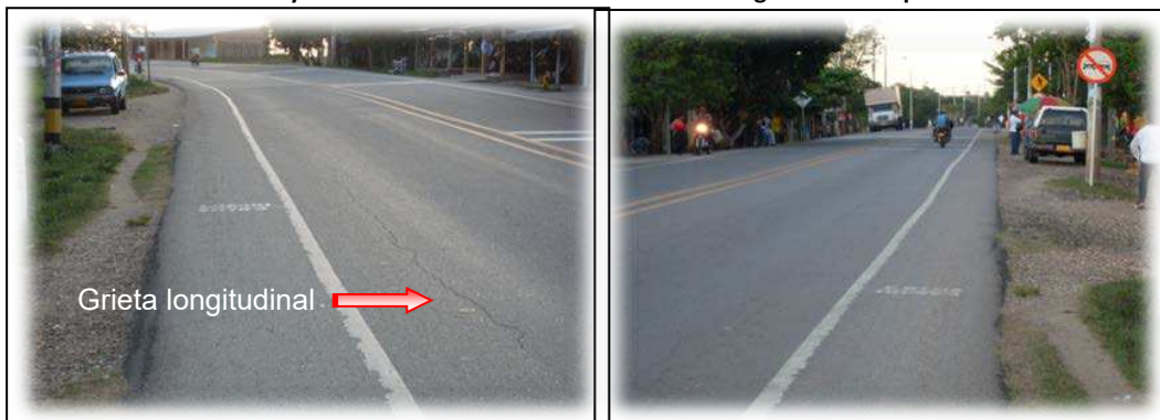
Figura A 1-2 Incidencia de los rayos solares en la observación visual de las grietas en un pavimento flexible
