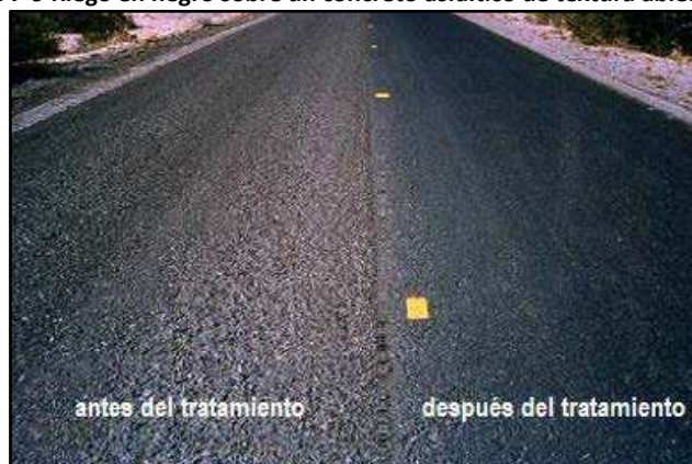
Figura 7-9 Riego en negro sobre un concreto asfáltico de textura abierta (7.7)
