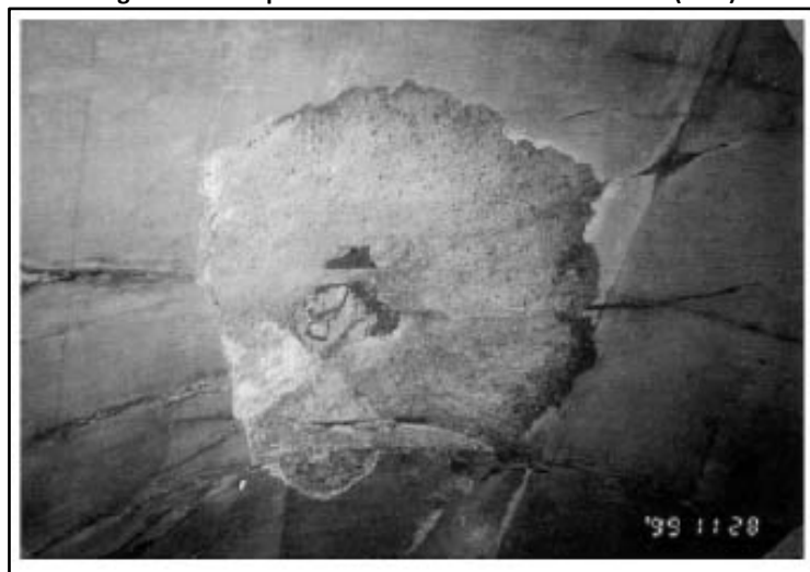
Figura 5-26 Desportilladura en el revestimiento final (5.31)
