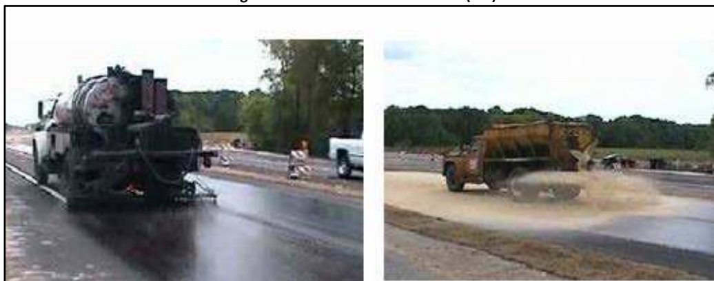
Figura 7-11 Sello de arena- asfalto (7.9)
