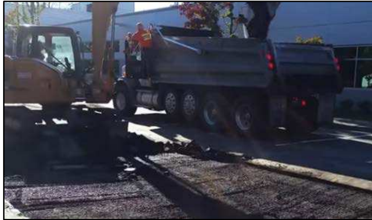
Figura 7-4 Remoción de material para el parcheo de un pavimento asfáltico
