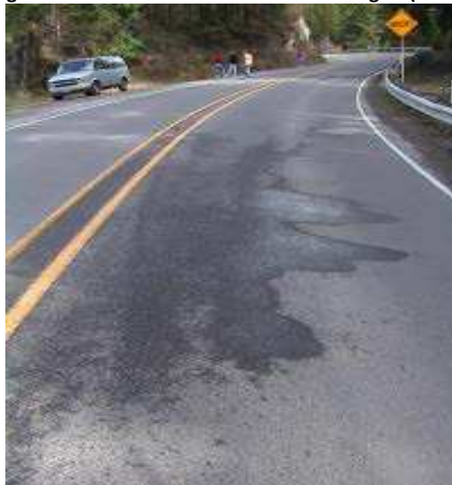
Figura C7A-4 Afloramiento excesivo de agua (H = 2)
