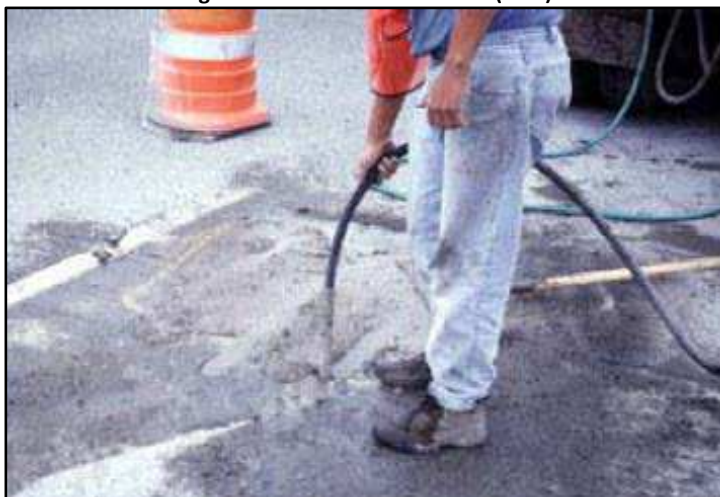
Figura 7-24 Vibrado del relleno (7.16)
