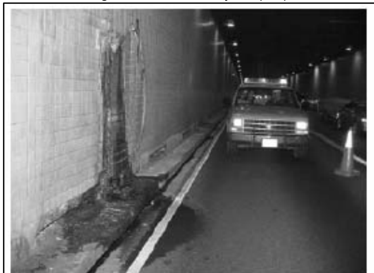
Figura 5-29 Filtraciones en juntas (5.33)
