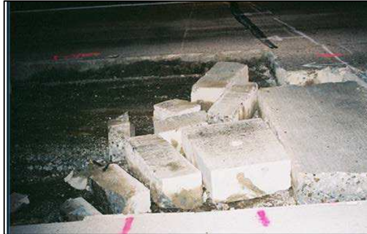
Figura 7-32 Piezas aserradas de tamaño manejable
