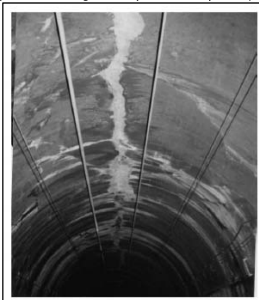
Figura 5-27 Grietas generadas por falla a compresión (5.31)
