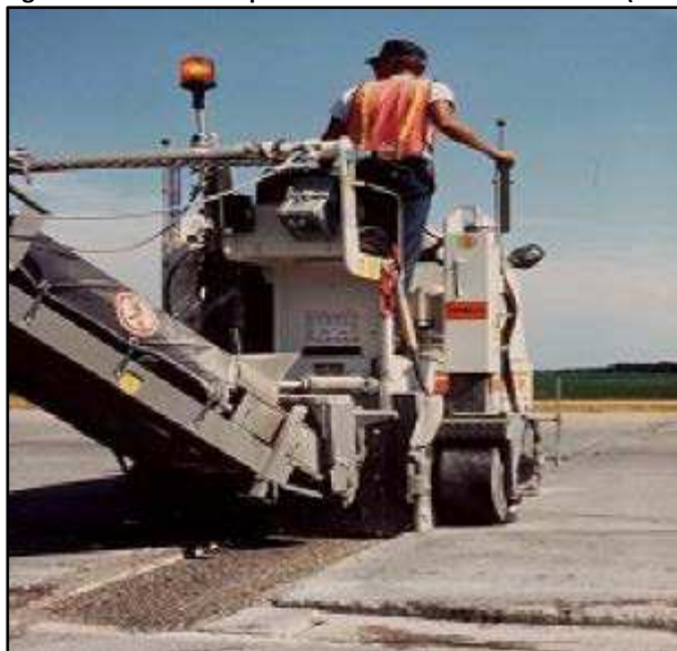
Figura 7-29 Remoción por fresado del material afectado (7.16)
