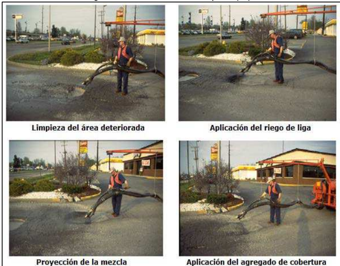
Figura 7-7 Parcheo lanzando la mezcla a presión (7.7)
