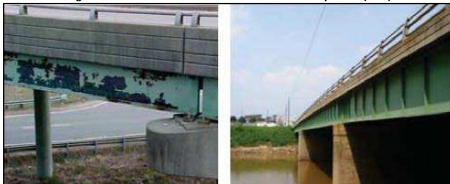
Figura 5-17 Protección contra la corrosión mediante pintura (5.20)
