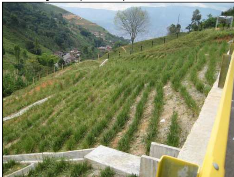
Figura 5-7 Implantación de pasto vetiver en un talud
