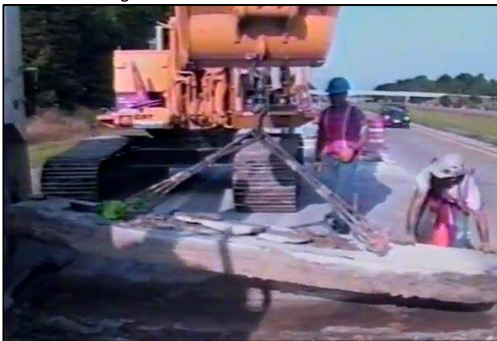
Figura 7-33 Izado de una sección aserrada
