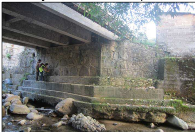
Figura 5-13 Socavación de estribo y aletas
