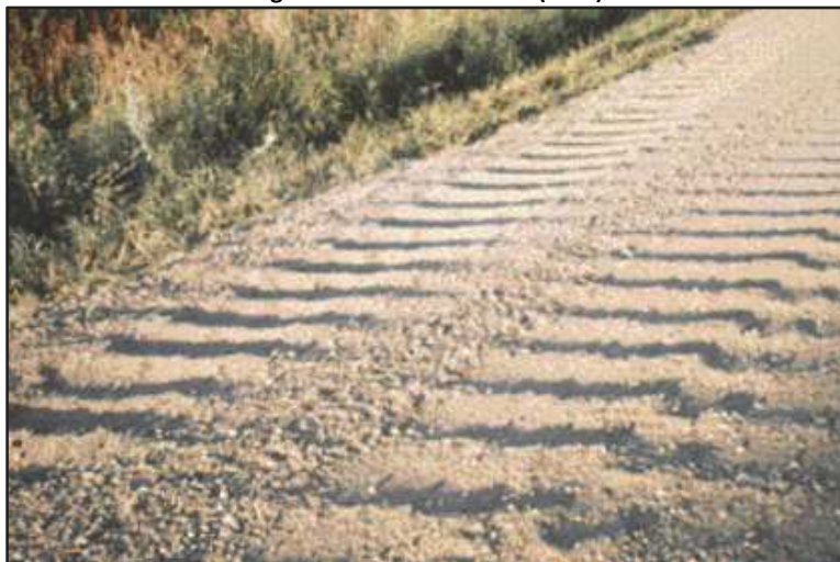
Figura A4-7 Ondulaciones (A4.7)
