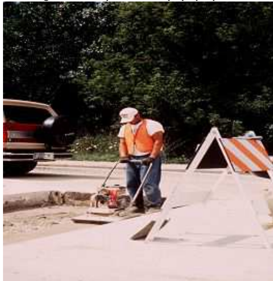
Figura 7-35 Superficie de apoyo preparada
