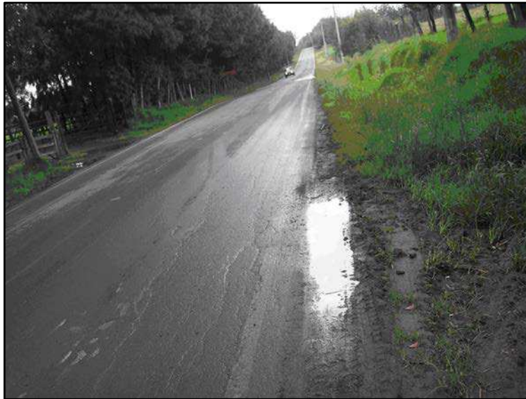
Figura C7A-3 Drenaje superficial ineficiente (A = 2)
