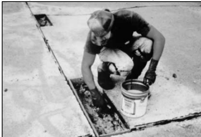
Figura 7-30 Aplicación de un mortero de cemento como puente de adherencia
