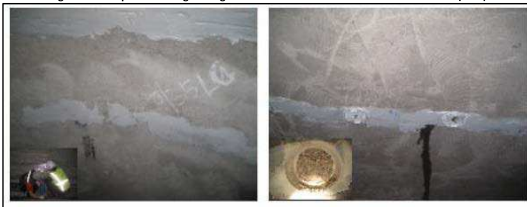
Figura 5-28 Reparación de grietas generadas con lechada de cemento estructural (5.32)
