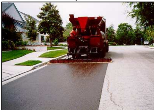
Figura 7-13 Mantenimiento de un pavimento con una lechada asfáltica
