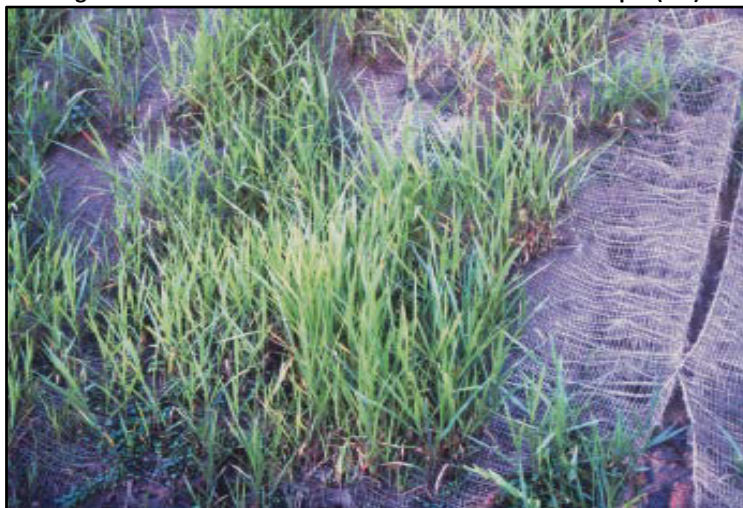
Figura 5-8 Protección de un talud con un biomanto de fique (5.6)
