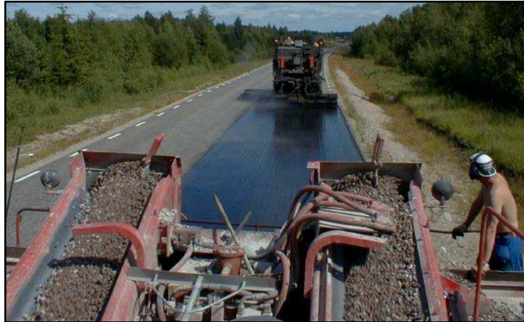
Figura 7-12 Mantenimiento periódico de un pavimento asfáltico con un tratamiento superficial (7.9)
