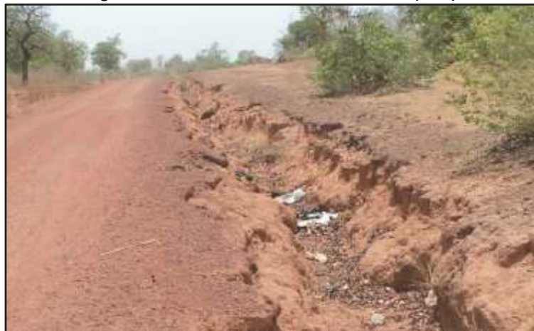
Figura A4-12 Erosión avanzada de una cuneta (A4.4)
