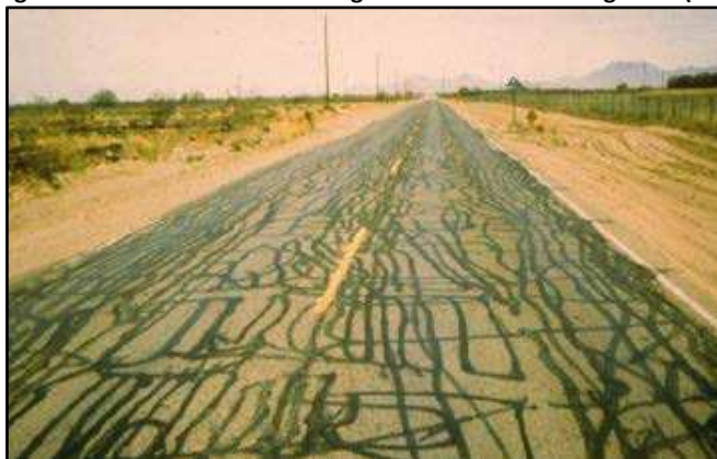
Figura 7-8 Pavimento con un exagerado tratamiento de grietas (7.7)
