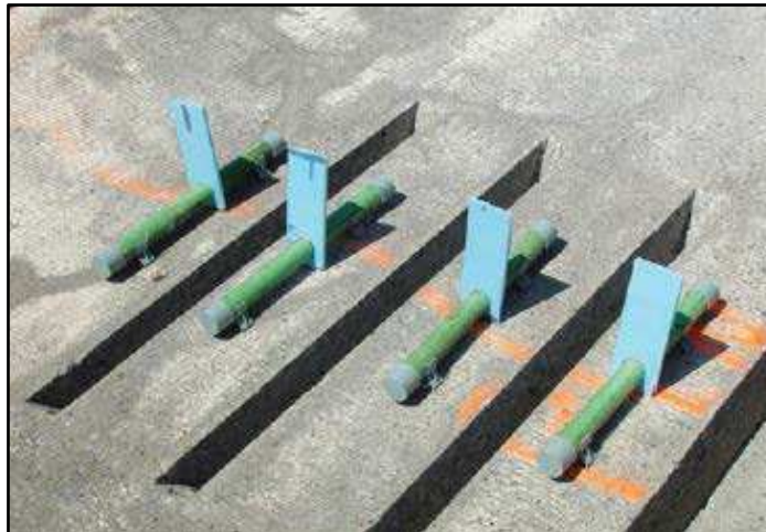
Figura 7-23 Ranuras y pasadores preparados para su instalación (7.15)
