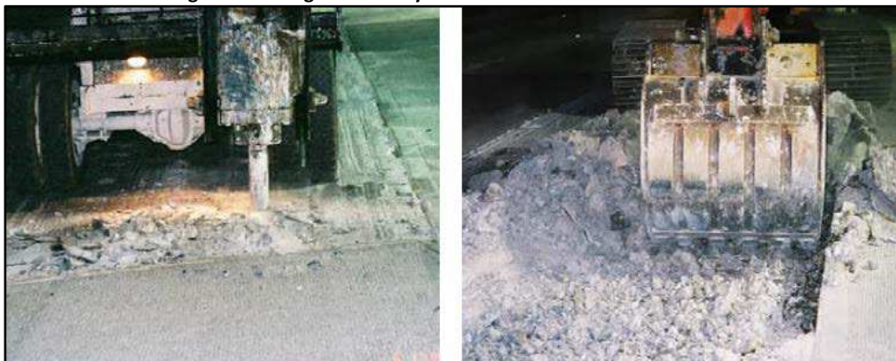
Figura 7-34 Fragmentación y remoción del concreto deteriorado
