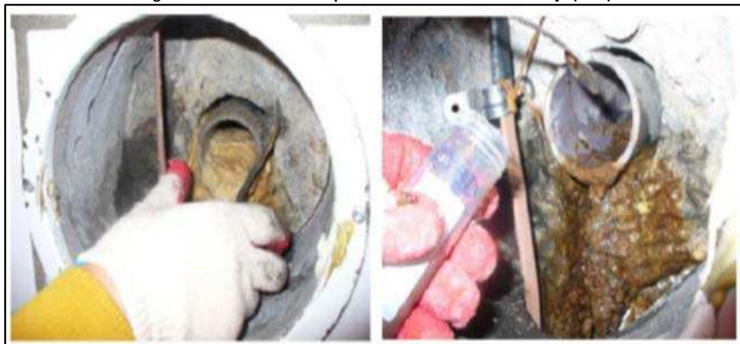
Figura 5-24 Mantenimiento preventivo del sistema de drenaje (5.28)
