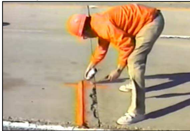
Figura 7-27 Demarcación del área por reparar
