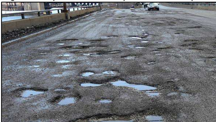
Figura 5-21 Desprendimientos de la capa de rodadura de un puente
