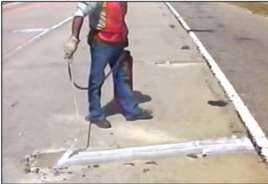
Figura 7-31 Curado del material de la reparación
