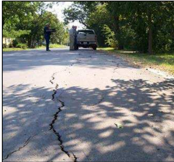
Figura C7A-6 Pavimento sobre un suelo de subrasante expansivo (S = 2)
