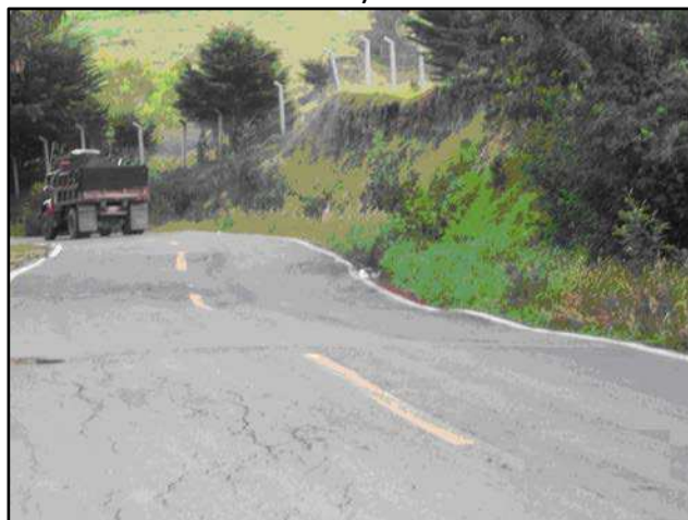
Figura C7A-5 Depresiones y deformaciones del pavimento por ausencia de dispositivos de drenaje interno (D =2)
