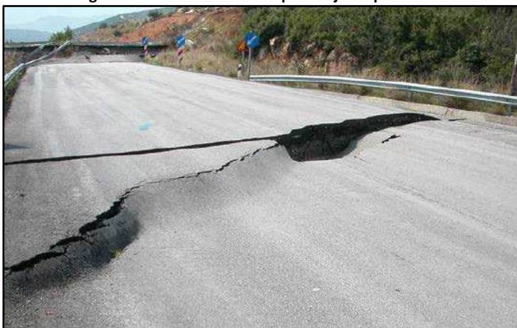
Figura A 1-3 Falla de un terraplén bajo un pavimento
