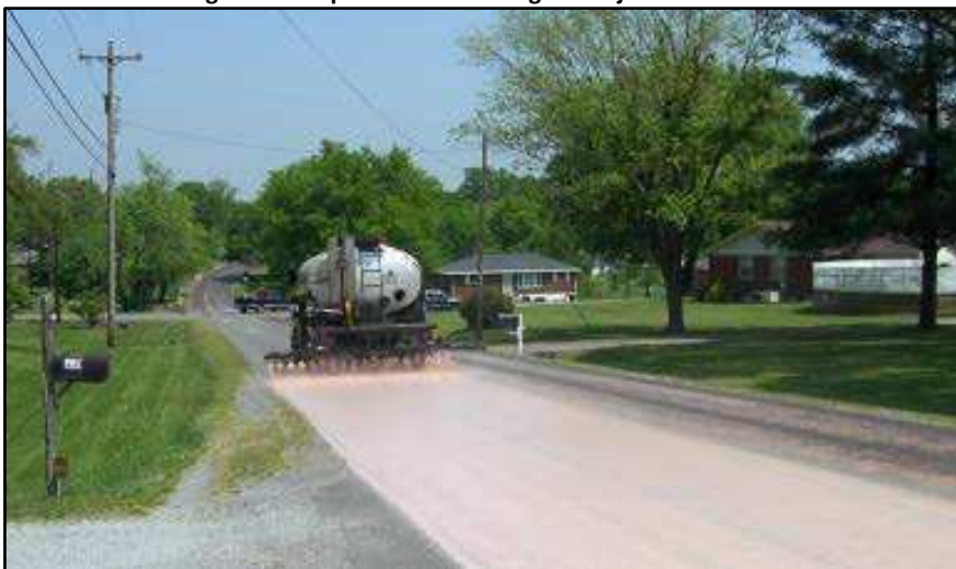
Figura 7-10 Aplicación de un riego de rejuvenecimiento
