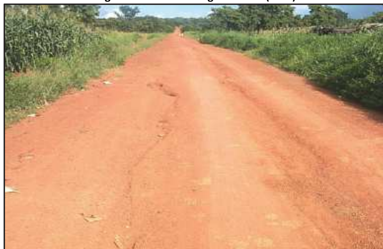
Figura A4-8 Surcos longitudinales (A4.8)
