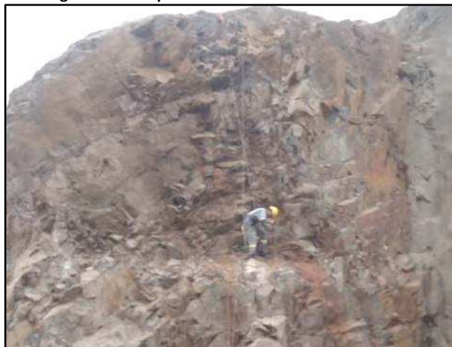
Figura 5-10 Despedrado manual de un talud de roca
