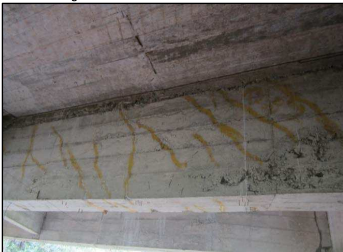
Figura 5-18 Fisuras en elementos de concreto
