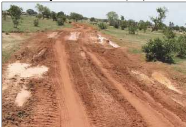
Figura A4-5 Ahuellamiento (A.4.4)
