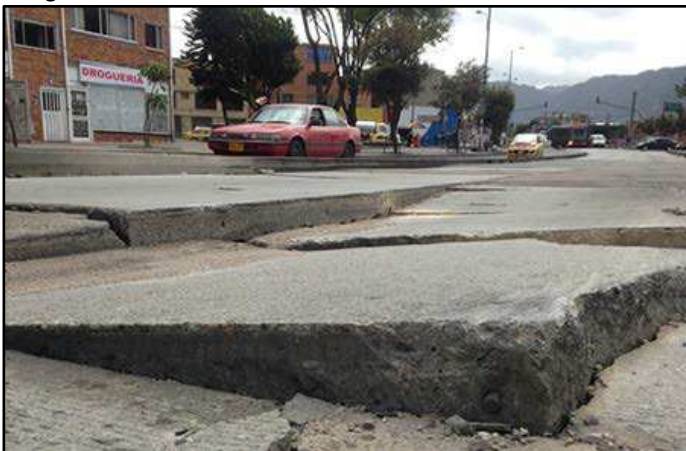
Figura 7-36 Destrucción de losas construidas sobre relleno fluido
