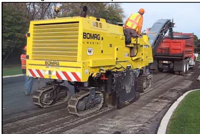
Figura 7-17 Fresado de un pavimento asfáltico
