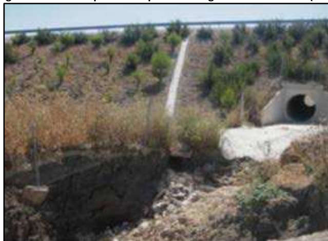
Figura 5-5 Cárcava producida por un desagüe mal construido (5.11)
