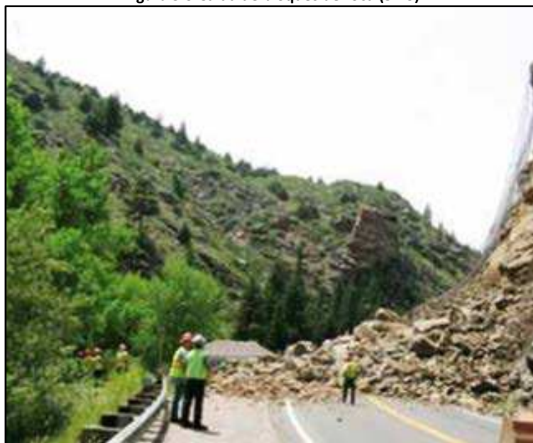
Figura 5-9 Caída de bloques de roca (5.13)
