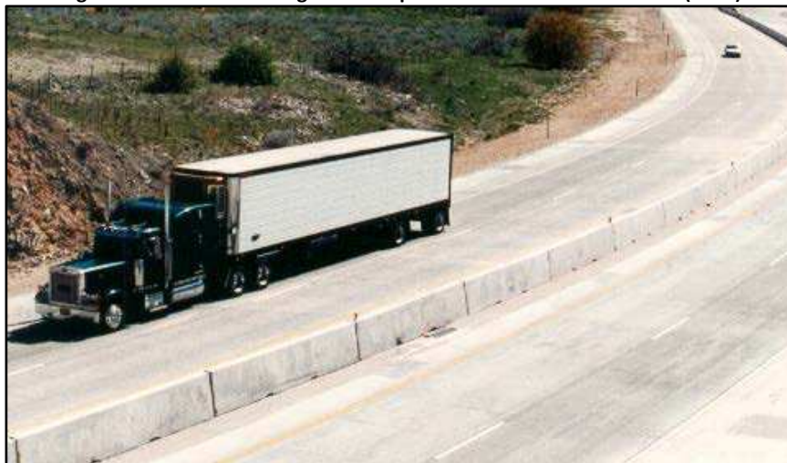
Figura C7A-2 Pavimento rígido con superficie en buenas condiciones (R = 0)
