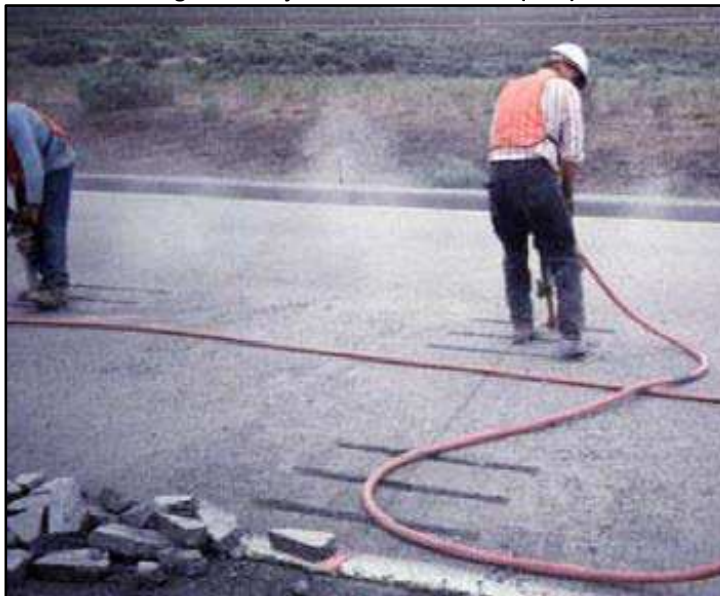
Figura 7-21 Ejecución de las ranuras (7.16)
