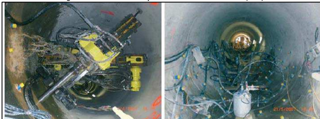
Figura 5-25 Perforación e inyección de lechada de contacto (5.26)
