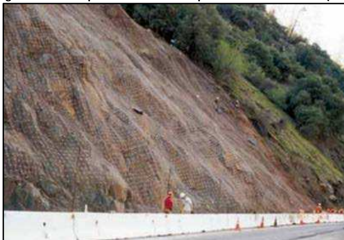
Figura 5-11 Malla para el control de desprendimiento de taludes (5.13)
