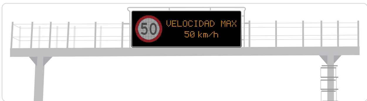
Figura 2-90. Soporte fijo metálico tipo pórtico, con SMV con panel gráfico y alfanumérico Tipo 2
