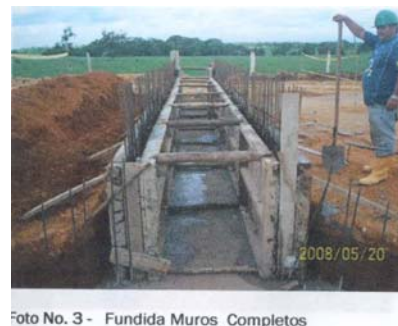
Foto No. 3 - Fundida Muros Completos
